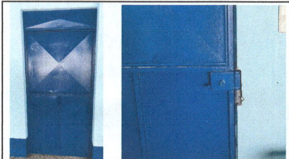
Foto 3: Mantenimiento a estructura (lijado, cambio de tubo, cepillado, sujetaciones, aplicación de pintura) (AULAS) Y Sustitución de chapa.
