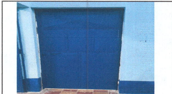
Foto 4: Sustitución de puerta
