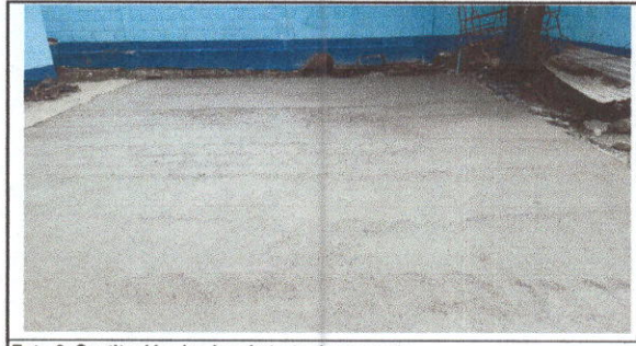
Foto 6: Sustitución de piso de torta de concreto
